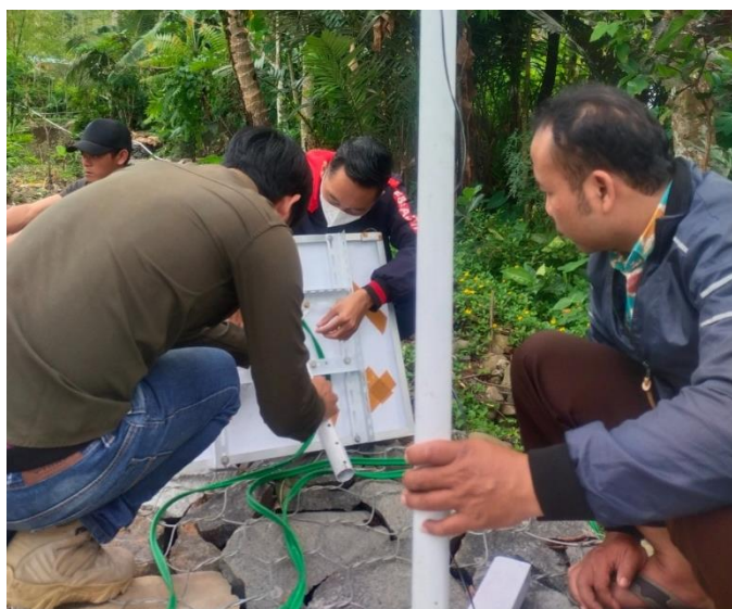
Pemasangan Solar Panel
